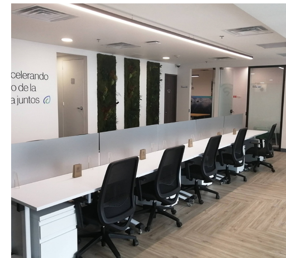
Remodelación de oficinas AES Colombia - sede Bogotá Fuente: AES Colombia, julio de 2021
