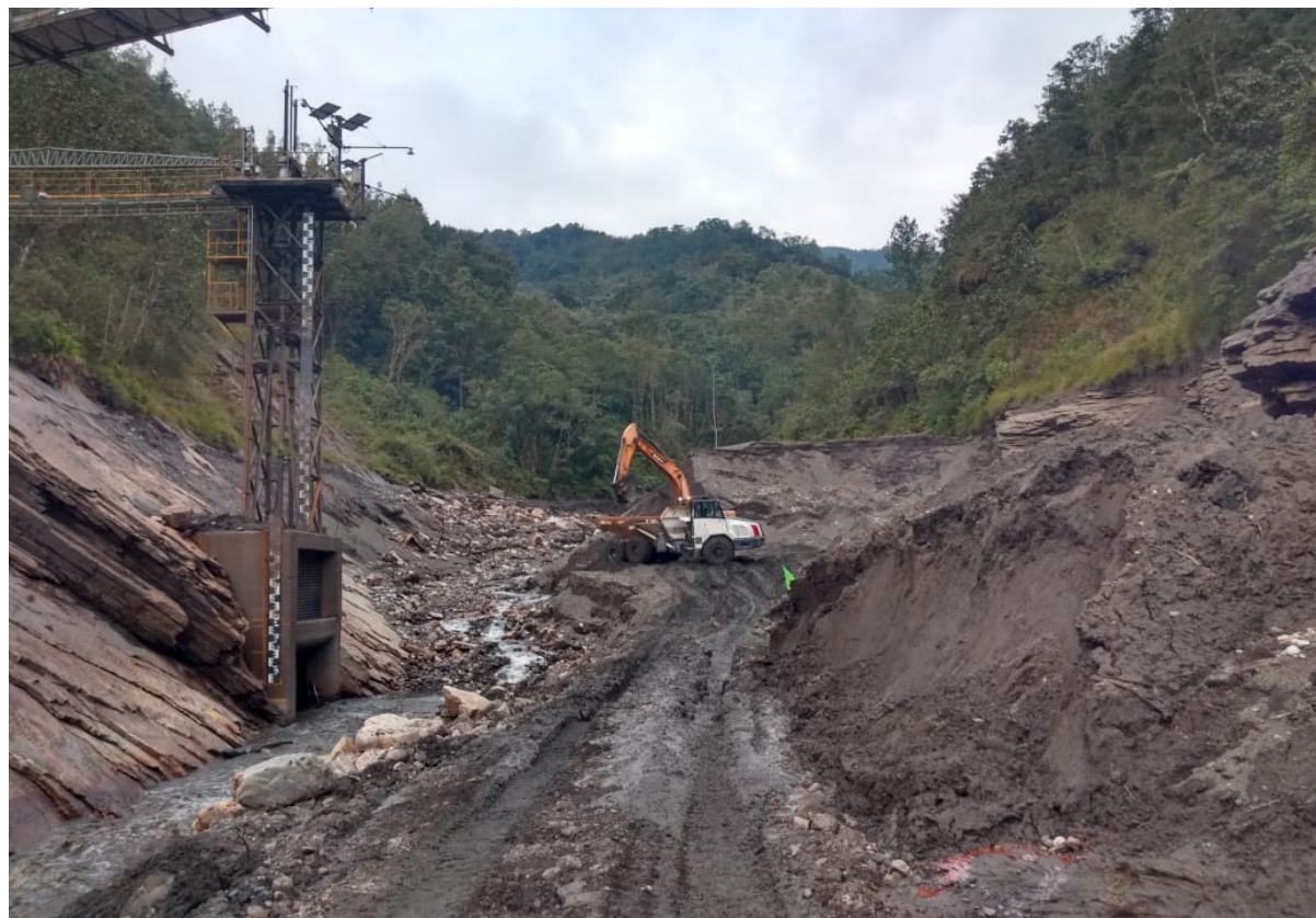
Intervención con maquinaria pesada - embalse Tunjita Fuente: AES Colombia, marzo de 2021
